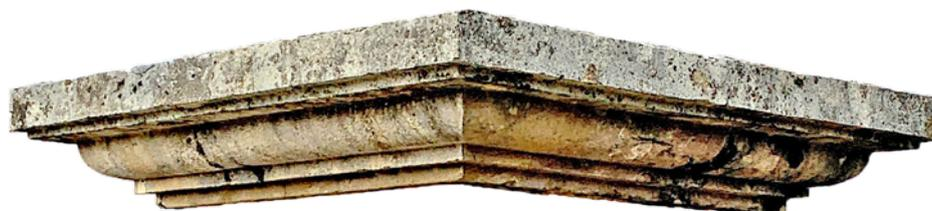
À noter la présence d'un fort tailloir parallélépipédique au-dessus de la corniche. Sa section horizontale est la même que celle du dé ou corps principal du piédestal.
