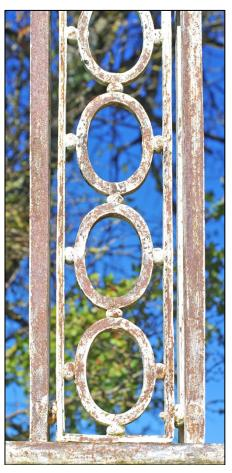
Venons-en à une autre spécificité ou originalité de la croix des Grangettes de Censeau : son fût intermédiaire élancé, constitué d'un panneau bidimensionnel (plan) inséré dans une structure tridimensionnelle à quatre montants structurels parallèles.
