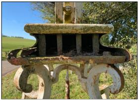
L'examen attentif de ce module montre que celui-ci comporte deux platines en fer reliées entre elles par un ensemble de petits "piliers" métalliques qui vont assurer la transmission de la charge. La platine basse repose sur les volutes des consoles alors que les montants verticaux du fût sont fixés à la platine supérieure. Ce dispositif judicieux nécessite toutefois un habillage externe (carrossage en tôle de fer).
