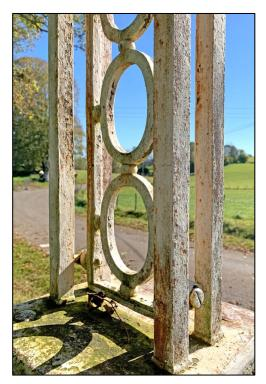
Le panneau bidimensionnel central est constitué d'un cadre métallique en fers de section carrée de faible dimension, au sein duquel est placée une chute de huit ovales métalliques. Ceux-ci sont fixés aux montants du cadre par l'intermédiaire de perles aplaties ; de même, des perles aplaties relient les ovales entre eux.
