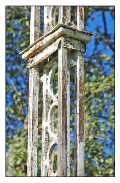
En partie haute du fût, un nouveau module de liaison permet d'assurer la continuité mécanique entre fût et croisillon sommital grâce à un système de platines parallèles. Une fausse moulure cache cette fixation. Un petit lambrequin en tôle découpée (sorte de tenture) a aussi été ajouté.
