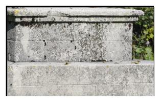
Une petite mouluration a été aménagée sur le haut du degré supérieur du socle. Sur les parois verticales, des traits réalisés dans le revêtement cimenté, cherchent à donner l'illusion d'un assemblage en plotets ou moellons maçonnés. Compte tenu de la hauteur déjà importante de la croix en fer et de l'empattement de la base aux consoles, il était certainement difficile de recourir à une forme traditionnelle de piédestal.
