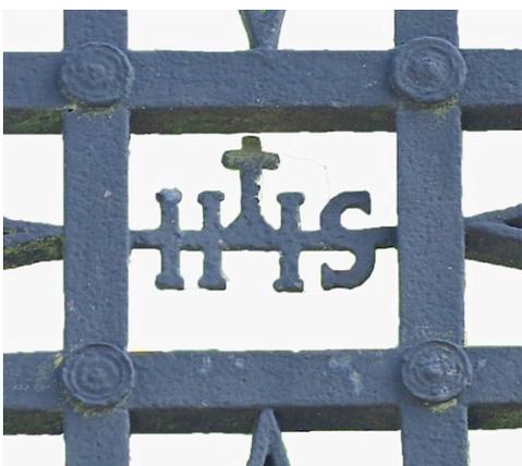
À noter que les rivets servant à bloquer les assemblages à mi-fer des montants structurels sont équipés de têtes circulaires originales en fer étampé.
