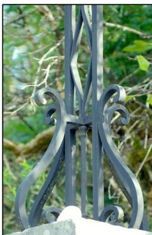
La croix est étayée en pied par quatre consoles en forme de S et à volutes. Elles sont placées sur les axes principaux de la croix (et non pas sur les diagonales du piédestal).
