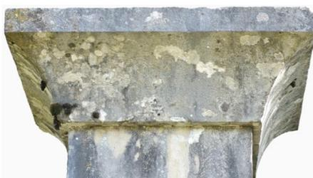
La corniche est également un bloc puissant ne comportant qu'une moulure concave en quart-de-rond surmontée d'un bandeau saillant. La corniche est d'une grande sévérité.
