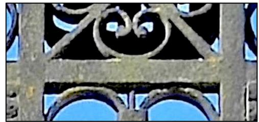
Des cœurs à volutes, en fer plat, sont fixés sur les barrettes d'extrémité des branches. On perçoit bien la différence entre les gros fers structurels de section carrée et les fers plats servant à la réalisation des décors et qui n'ont qu'une faible contribution à la résistance mécanique.
