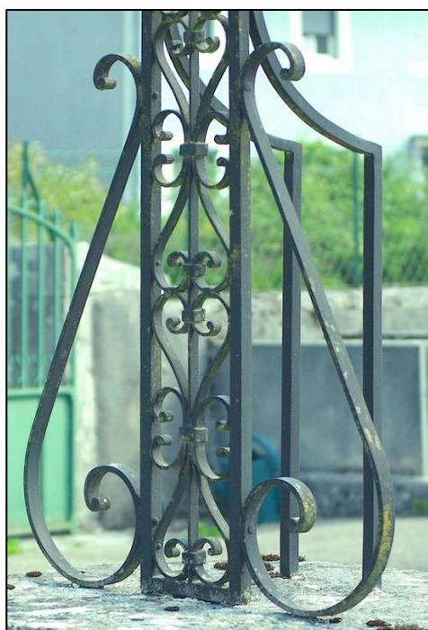
Les deux consoles latérales, réalisées en fer plat, sont de style classique en S et comportent un gros rouleau en bas et juste une petite volute en haut. La partie intermédiaire est très rectiligne, faisant penser à un travail du fer de type moderne. Les consoles sont fixées, en haut et en bas, sur les montants structurels par de discrets rivets. Les rouleaux bas sont, eux, fixés sur la pierre du socle-piédestal.
