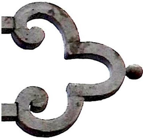
En l'absence de barrette orthogonale d'extrémité, les fers structurels parallèles sont reliés entre eux par des culots trilobés en fer de section carrée, symbole trinitaire traditionnel.
