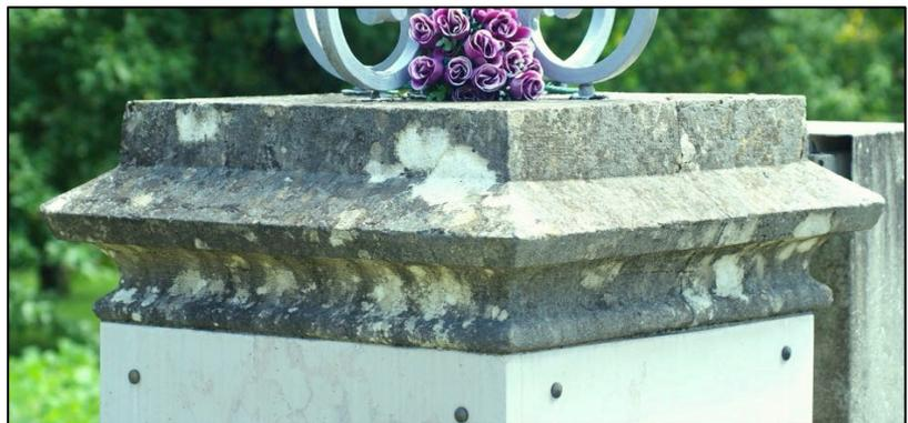
Quant au dé, ou corps principal, du piédestal, il est recouvert de plaques de marbre posées sans doute tardivement pour cacher de possibles dégradations de la pierre calcaire. Le dé - revêtu de marbre - présente le même contour extérieur que celui du bas de la corniche et pourrait donc correspondre au dé d'origine. Le bloc formant la base à haute plinthe pourrait alors avoir été supprimée, le dé revêtu de marbre étant replacé sur la petite base actuelle.
