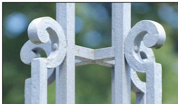
Les deux montants verticaux complémentaires formant la hausse de la base sont coudés en biais pour venir s'achever en biseau et s'appuyer sur la barre horizontale haute d'entretoisement (à noter le rivetage des têtes des boulons).
