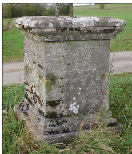
La base du piédestal comporte une mouluration avec réglelet surmonté d'un quart-de-rond déformé.
