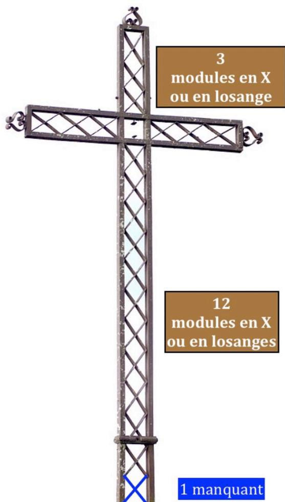
Entre les deux fers structurels, l'espace créé fait l'objet d'un remplissage décoratif caractéristique des croix du type "polinois". Il s'agit de fers plats pliés ou coudés de façon à créer visuellement des "pseudo-losanges". On peut aussi voir dans ce motif des X formant ribambelle ou guirlande.
