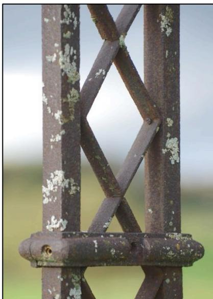
Le décor de remplissage entre les deux montants structurels parallèles est réalisé en fer plat. Ce sont deux longs fers, régulièrement coudés et se croisant à "mi-fer" qui forment ce décor à l'apparence d'une ribambelle de "pseudo-losanges" ou de X.
