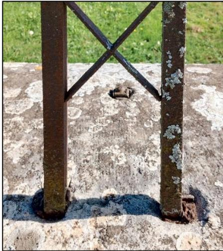
La structure porteuse bidimensionnelle (2D) de la croix comporte deux gros fers parallèles, de section carrée. Ils sont scellés dans la corniche en pierre puis montent jusqu'au sommet de la croix : les deux fers identiques de la traverse s'y accrochent.
