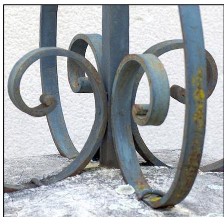
Les fers plats des consoles sont fixés sur la barre montante par le biais de discrets rivets, aussi bien en partie basse qu'en partie haute.
