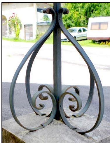
La barre verticale est soutenue, en pied, par quatre consoles en fer plat. Celles-ci sont placées non pas sur les diagonales du piédestal mais sur les axes principaux de la croix (donc perpendiculaires aux faces du piédestal).
