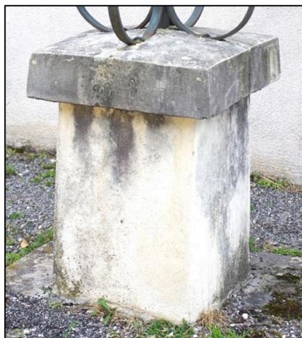
La corniche, simple et débordante, est bombée. Les fers des consoles y sont fixés par des crochets ancrés dans la pierre.
