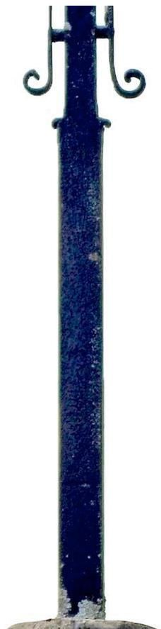
Le montant vertical formant fût-colonne est un grand fer de section rectangulaire. Il ne comporte aucune console de soutien. Ce fer est scellé dans la base de colonne en pierre.
