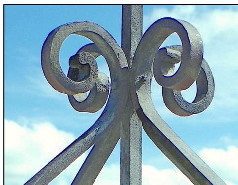
Au niveau des rouleaux hauts, les quatre fers plats des consoles viennent se coller sur la barre centrale où ils sont fixés par des boulons et des rivets. Le dispositif d'assemblage est loin d'être sophistiqué.
