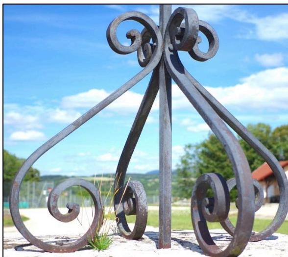
Au niveau des rouleaux bas, les fers des consoles s'écartent fortement du bas de la barre centrale montante. Ils sont scellés et boulonnés sur la pierre de la corniche.
