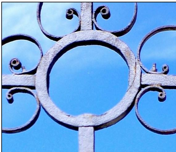
L'anneau central est lui-même un fer de section carrée assez importante. Cet anneau a été obtenu à la forge par courbure d'un fer plat : on peut aisément apercevoir le raccord en biseau entre les deux extrémités du fer.
