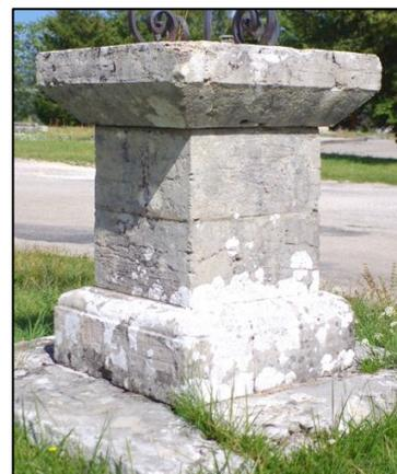
Ce piédestal est de forme globalement parallélépipédique et de section carrée. Sa base comporte une haute plinthe surmontée d'un fort quart-de-rond. Sa corniche se présente avec sa partie inférieure (sous-face) chanfreinée. Les faces du dé ou corps principal ne sont pas travaillées : le dé est composé de deux blocs de calcaire simplement superposés.
