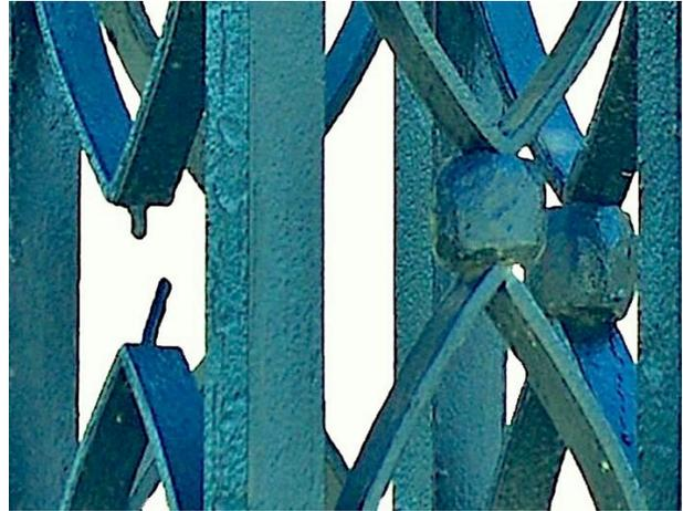
Entre les deux répliques haute et basse du motif élémentaire, les fers plats sont maintenus assemblés par des perles creuses en forme de tonneau se fixant sur des pointes aux extrémités des grosses amandes : la disparition d'une de ces perles en tonneau permet de bien voir et comprendre ce dispositif particulier de fixation.
