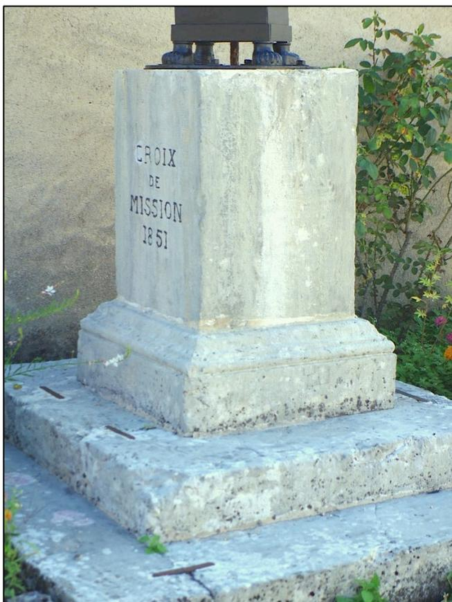
Le piédestal repose sur un emmarchement à deux degrés, formé de belles dalles en calcaire, solidarités par des agrafes en fer. Le piédestal est globalement parallélépipédique et de section carrée.
