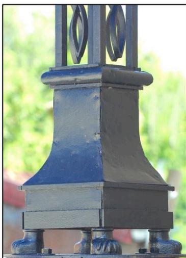
Une seconde platine permet la fixation des quatre pieds à sabots. Une liaison entre les deux platines assure la continuité mécanique.
