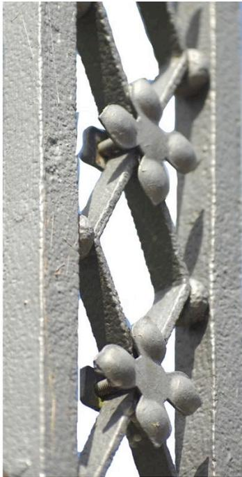
Des fleurettes à quatre pétales et en tôle de fer découpée sont fixées sur les fers aux losanges, et cela sur les deux côtés de la croix. Elles cachent l'assemblage à mi-fer des deux barres pliées formant les losanges.
