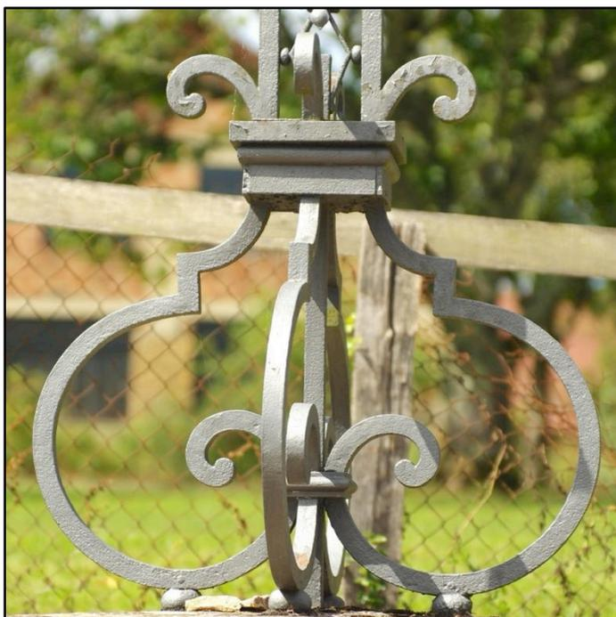
Quatre consoles d'étaie sont positionnées sur les axes principaux de la croix (et non pas selon les diagonales de la corniche). Les fers des quatre consoles viennent se solidariser à la tige centrale en bas et au dé de liaison en haut. En bas de la structure, les fers des consoles sont fixés et maintenus sur la corniche en pierre par l'intermédiaire de belles perles de fer estampé
