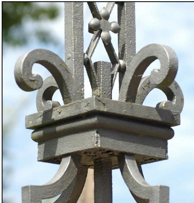
Un important dé ou dispositif de liaison entre base et pied du fût vient serrer tous les fers ensemble. Il est constitué de plaquettes rectangulaires maintenues par un cordon torique. Une platine carrée est ajoutée au-dessus de cette molure torique.
