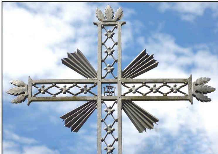
Les duos de fers structurels des branches se croisent et sont assemblés "à mi-fer" (entailles de demi-largeur), avec ajout de petits rivets de fixation.
