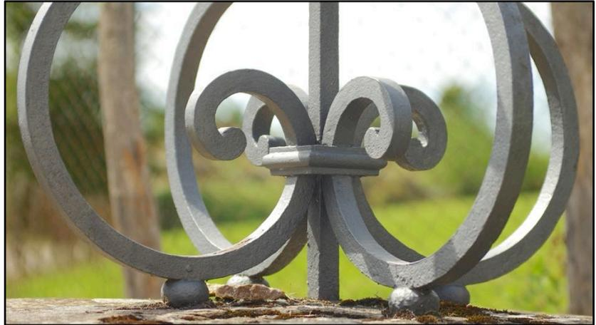
Ces fers des consoles sont tenus serrés sur la tige centrale montante par le biais d'un fort collier à baguette.
