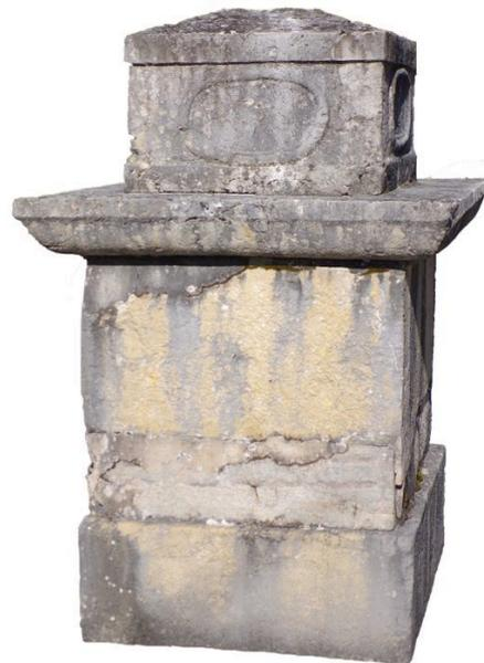
La base et le dé ne présentent aucune mouluration, ni aucune inscription. La corniche saillante est une belle dalle carrée comportant trois sobres moulures : un petit réglet (presque invisible), une généreuse doucine et enfin un plus important réglet ou bandeau vertical.
