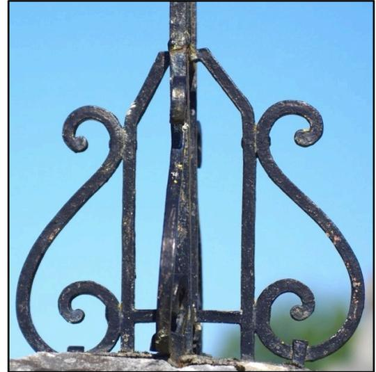
Les assemblages des fers sont à tenons et mortaises avec têtes rivetées.
