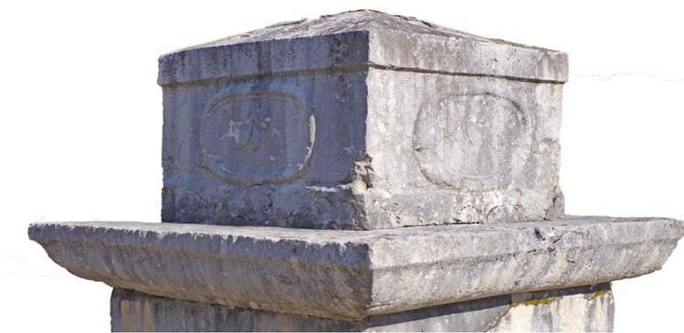
Il s'agit d'un beau bloc parallélépipédique sur plan carré. Sa partie supérieure est taillée en pyramide aplatie.
