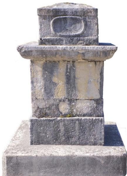
Le piédestal, posé sur un emmarchement en béton à deux degrés, est une structure peu banale en calcaire.
