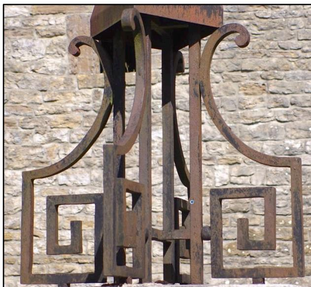
Deux dispositifs d'entretoisement horizontaux en X sont placés en partie basse (ci-dessous, à gauche) et en partie haute (ci-dessous, à droite) de la base-tabouret pour relier et solidariser les quatre montants verticaux. Leurs fers constitutifs sont assemblés à mi-fer.
