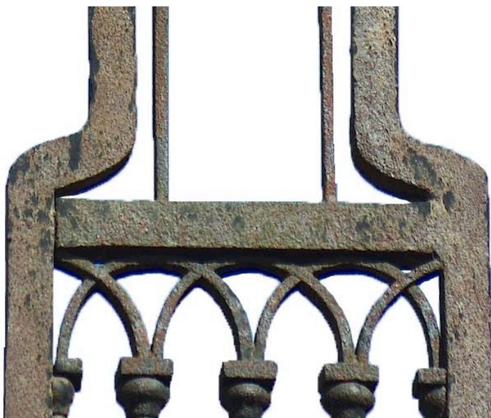
Au-dessus des arcatures ogivales, les fers structurels bordiers sont reliés entre eux par une entretoise horizontale (assemblage par tenon et mortaise).
