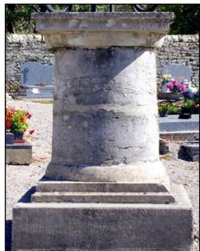
Le piédestal repose sur un socle parallélépipédique cimenté, moderne, avec deux petites plinthes décalées. De même la base du piédestal (sous le cylindre) est de facture moderne avec une moulure à profil courbe élancé.
