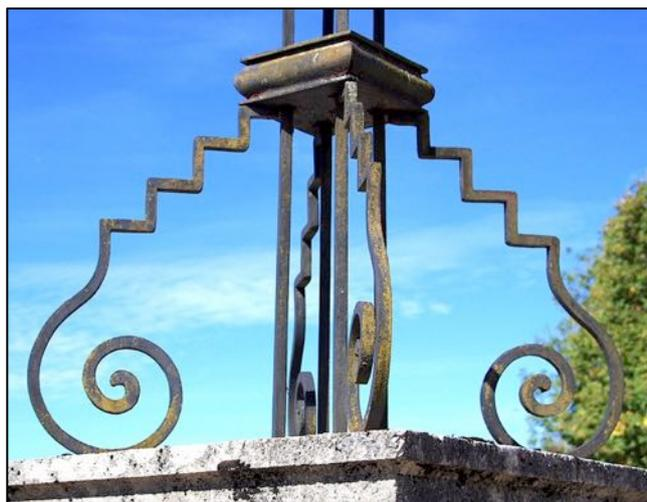
Le fût métallique de la croix est scellé dans la corniche en pierre. Il est soutenu, à la base, par quatre consoles en fer forgé, placée selon les diagonales de la corniche (à 45° par rapport à l'axe majeur de la croix).
