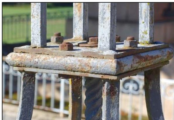
Les fers montants de la base et du fût sont fixés par soudure à de petites platines carrées peu épaisses. Ces deux platines (basse et haute) viennent prendre en sandwich une 3<sup>ème</sup> platine plus importante et dont les bords sont à profil torique. L'ensemble du dispositif de liaison est assemblé par de gros boulons. La tige centrale torsadée est, elle-aussi, fixée par boulonnage à la platine haute.
