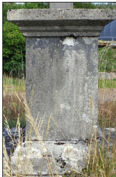
Le piédestal, proprement dit, présente une base avec plinthe, moulure en quart-de-rond et petit réglot. Le dé qui s'élève sur cette base est un bloc monolithique parallélépipédique, de plan carré, plutôt élevé : il ne comporte aucune inscription.
