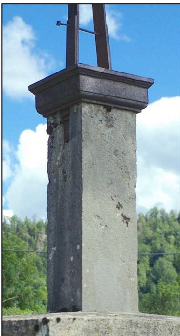
Plus intrigant est le petit fût-colonne placé sur le piédestal. Bloc parallélépipédique posé de chant, il semble avoir pour fonctions d'une part d'élever la croix métallique, d'autre part de permettre la fixation de la partie fer sur la partie pierre.
