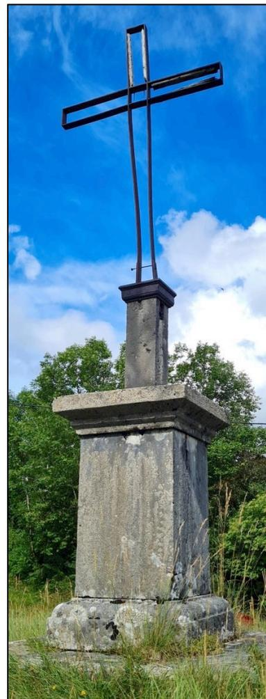
La partie non métallique de la croix voit se superposer, de bas en haut, un dallage en blocs de pierre calcaire, un piédestal de forme classique et un étrange fût-colonne.
