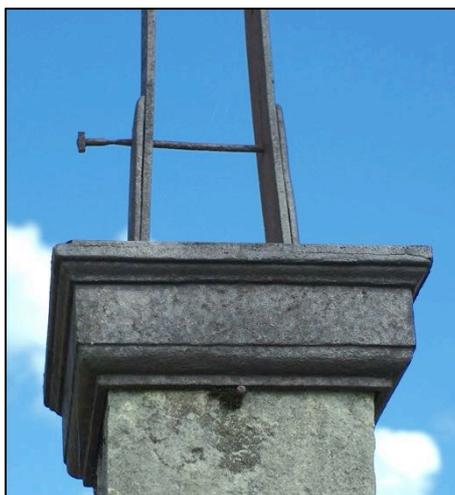
Une tige en fer avec vis et boulons assure le blocage de la fixation.
