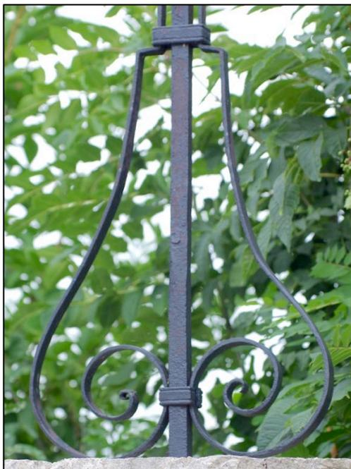
Les fers plats qui montent le long de la croix de chaque côté de la barre structurelle sont forgés de façon à constituer des ailerons placés sur le plan principal de la croix.
