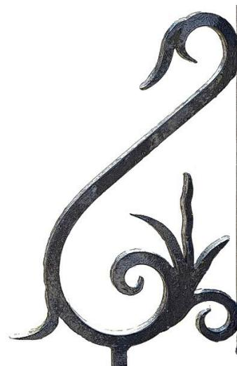
De petits pieds droits fixés aux rouleaux bas des consoles permettent le scellement dans la pierre du bloc-socle.
