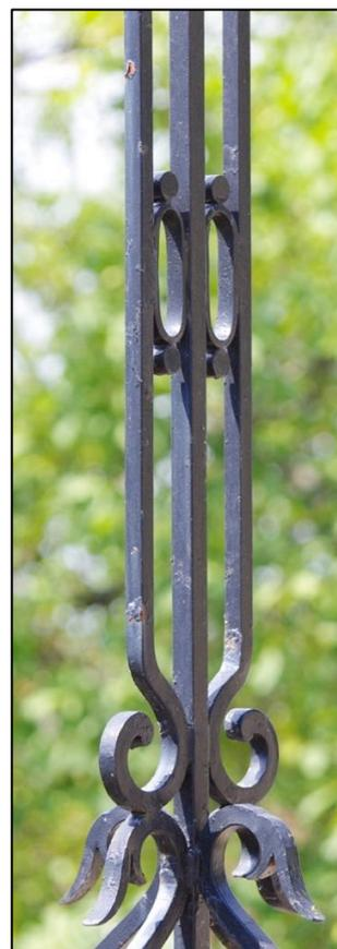
En bas du pied, les fers carrés sont forgés de façon à former de belles volutes venant se positionner contre la barre structurale centrale et s'appuyer aussi sur les volutes des consoles.
