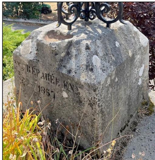
La croix en fer forgé est scellée sur un bloc de pierre calcaire, monolithique, de forme globale parallélépipédique et de section carrée. Ce bloc-socle repose sur une grande dalle en béton (ou pierre cimentée) de section carrée formant emmarchement à un degré. Les bords supérieurs du bloc-socle ont été chanfreinés (en tronc de pyramide).
