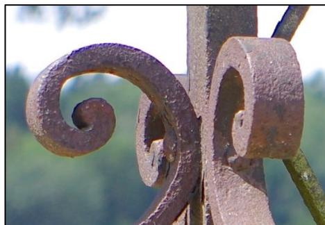
La fonction mécanique (résistance au renversement de la croix) de ce dispositif à six petites consoles aplaties reste limitée alors que la croix est particulièrement haute.
