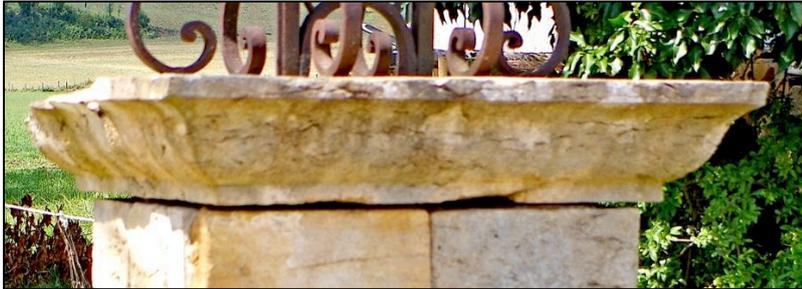
Au-dessus du dé en moellons, une corniche permet la fixation des fers de la croix. C'est un autre bloc monolithique comportant une succession de moulures : réglet, doucine et petit bandeau.
