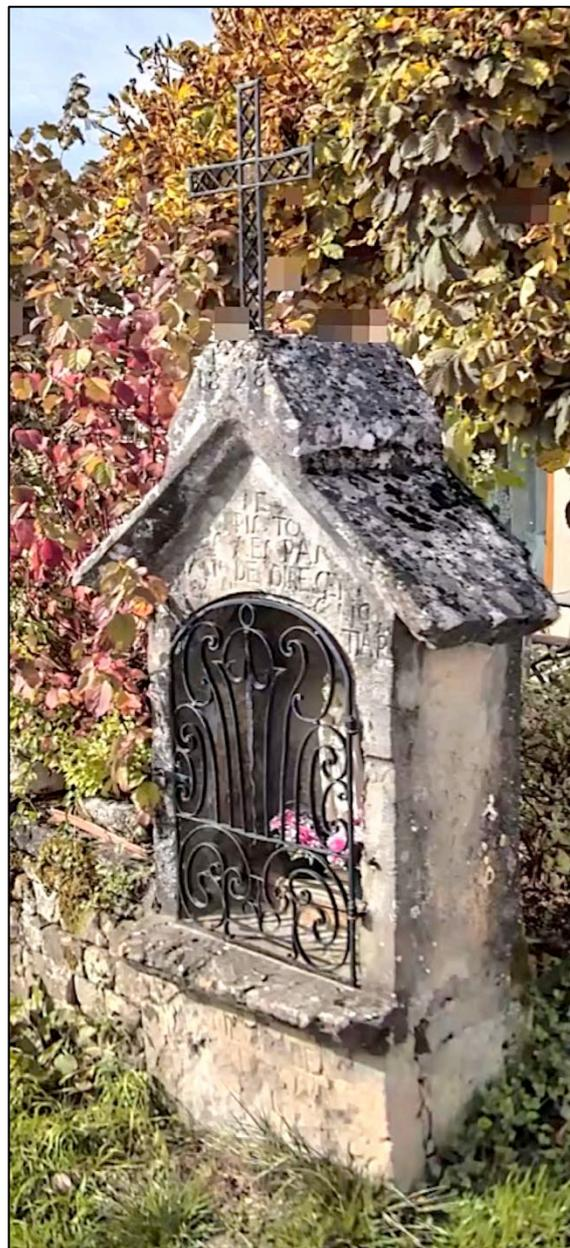
La croix en fer forgé date très vraisemblablement d'une restauration de l'oratoire réalisée en 1828. Relevant du corpus du type "polinois", avec sa structure bidimensionnelle, plane, elle comporte en effet un décor de remplissage à motifs de "pseudo-losanges", réalisé en faisant se croiser et s'assembler "à mi-fer" deux barres en fer plat.
