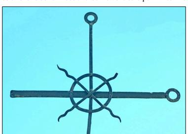
Aux extrémités des branches libres sont fixés de petits anneaux en fer plat. La fixation est faite par rivetage sur les fers structurels après aplatissement de ceux-ci.
