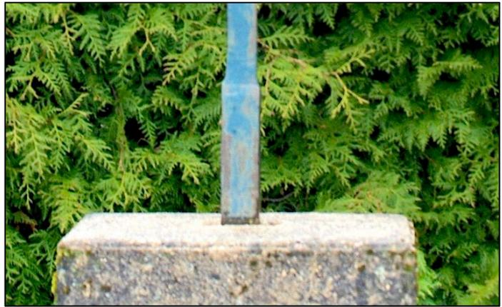
Le bas du pied, légèrement élargi, est simplement scellé dans le béton du socle.
