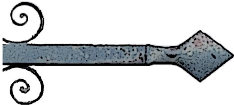
Les extrémités des trois branches libres sont terminées par des pointes de lance en forme de losange. Elles sont réalisées par simple aplatissage et découpage des fers structurels.
