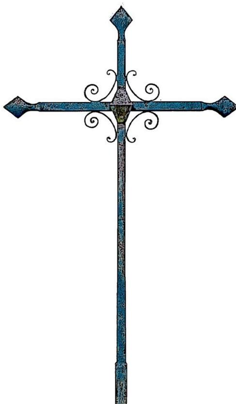
La partie métallique du monument se présente sous la forme d'une croix latine en fer plat (à section rectangulaire). La structure unidimensionnelle comporte un pied vertical élançé croisant une traverse horizontale plus petite.
