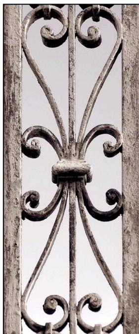
Ce décor de remplissage est constitué d'un même module répété tout au long du fer plat central ou de liaison. Il est constitué de motifs doublement symétriques en fer plat forgé en forme de C et de volutes. Les fers décoratifs sont tenus ensemble par un collier à baguette enserrant aussi le fer central.
