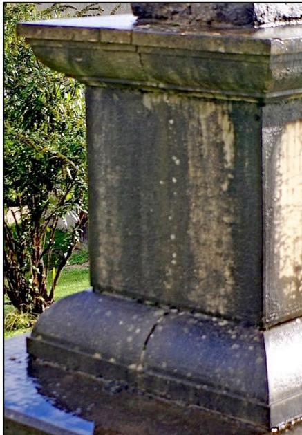
Le dé ou corps principal du piédestal est, lui, un bloc parallélépipédique monolithique, avec également bouchardage des quatre faces.
