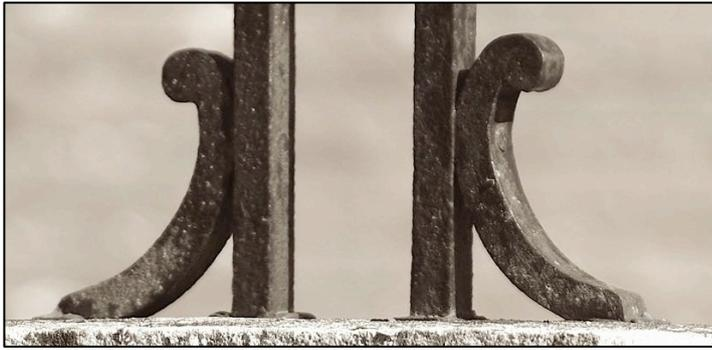
Deux petites consoles latérales en fer de section carrée viennent s'appuyer sur les montants porteurs des croix. En forme de C, elles se terminent par un petit noyau en rouleau en partie haute (fixation par vis ou rivet). Elles semblent être enfoncées et scellées dans la pierre des socles en partie basse.
