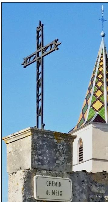
Les quatre croix sont à structure bidimensionnelle 2D, réalisée avec des duos de gros fers parallèles, de section carrée.
