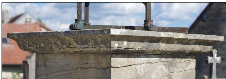
Le dé ou corps principal du piédestal est constitué de deux blocs parallélépipédiques superposés, ne comportant aucune mouluration.
