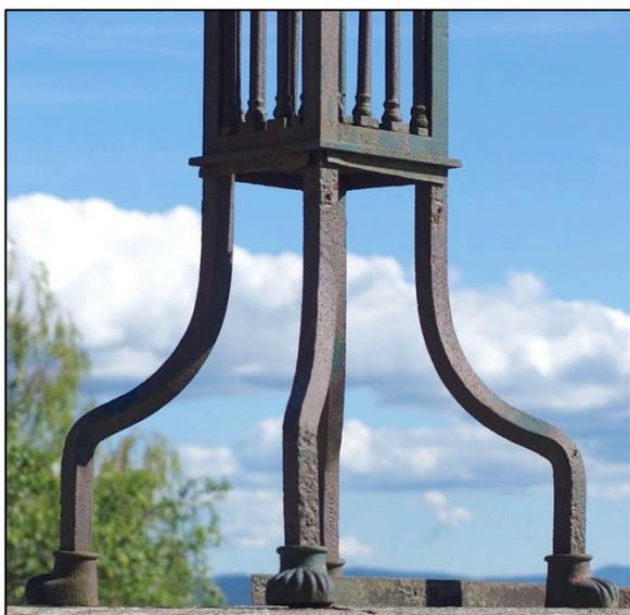
Le tabouret est constitué de quatre fers de section carrée dont on peut penser qu'ils se prolongent dans le fût-cage pour en former les montants structurels. Les fers sont courbés de façon à élargir l'assise du tabouret.
