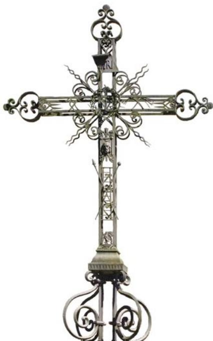
En partie basse, un socle ou base est constitué de quatre montants parallèles en fer de section carrée. Quatre consoles orientées selon les diagonales de la corniche du piédestal s'y fixent, contribuant à stabiliser la croix.
