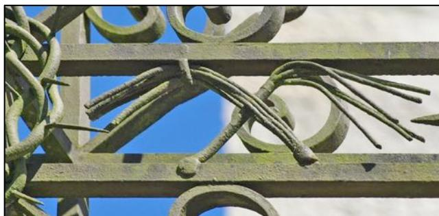
Les branches libres se terminent par des platines en tôle, vissées aux fers de structure
