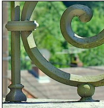
De petits sabots permettent de renforcer l'ancrage des montants structurels sur la pierre de la corniche. Les fers des consoles viennent se fixer sur ces montants structurels par l'intermédiaire de puissants colliers moulurés réalisés en demi-coquilles. L'assemblage est complexe du fait des orientations différentes des faces des fers des montants et des consoles.
