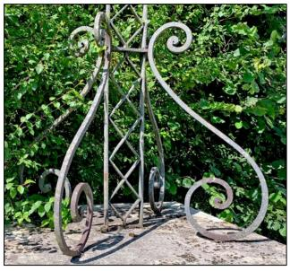
La croix est stabilisée à la base par quatre consoles, en fer de section carrée, placées selon les diagonales du piédestal.
