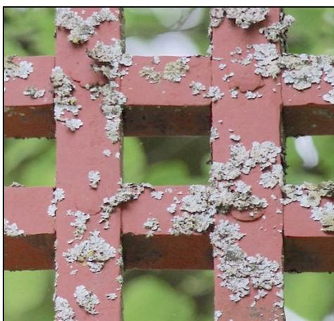
À la croisée des branches, les montants structurels sont assemblés "à mi-fer" (fers entaillés à moitié). Des rivets à têtes bien aplaties assurent la fixation de l'ensemble des fers. Ce dispositif technique donne une impression de grande stabilité et résistance mécanique mais reste esthétiquement quelque peu maladroit.
