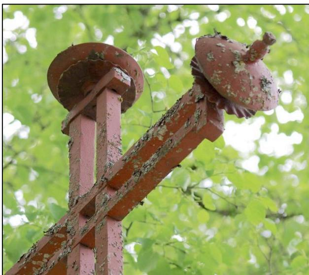
De fortes barrettes en fer de section carrée relient les fers structurels parallèles : ces derniers viennent s'enficher dans les barrettes (avec bouts rivetés).
