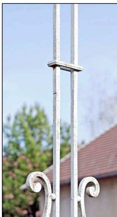
Le fût ne comporte en effet aucun décor. Les deux fers structurels, de section carrée, montent parallèlement vers le sommet de la croix. On relève toutefois la présence d'un collier à baguette placé à mi-hauteur du fût servant à éviter l'écartement des deux montants ou leur flambement.
