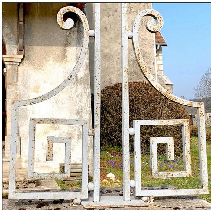
Les consoles latérales semblent avoir une fonction plus décorative que structurelle (en principe, assurer la stabilité de la croix métallique) : elles ressemblent plutôt à des ailerons juste fixés aux montants du fût.
