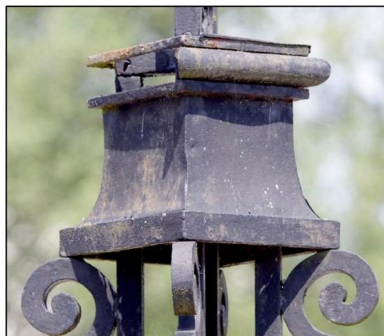
Deux des quatre montants de la base (les fers latéraux) poursuivent leur ascension au delà de la base pour former les montants du fût-pied bidimensionnel. Les deux autres montants (en avant et en arrière du plan principal de la croix) viennent se fixer, eux, sur un étrier-entretoise et une platine de section carrée ; ils arrêtent leurs ascension à ce niveau, sous le capot.
