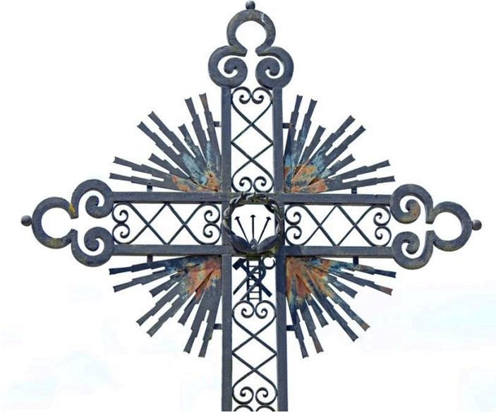
Les fers de structure (verticaux et horizontaux) se croisent avec des assemblages discrets à "mi-fer".
