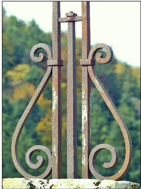
Une barre verticale de renfort a été ajoutée, entre les deux fers structurels montants. Elle vient s'ancrer par boulonnage sur une entretoise solidarissant les deux montants verticaux. Ce renfort du pied va accroître la résistance mécanique de la croix métallique.
