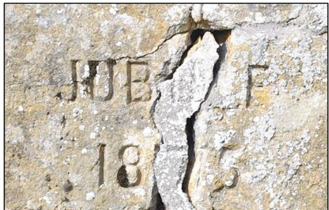
On constate aisément que du ciment a été déposé dans un vide de la pierre et que l'on a gravé l'inscription et la date par-dessus la partie cimentée.
