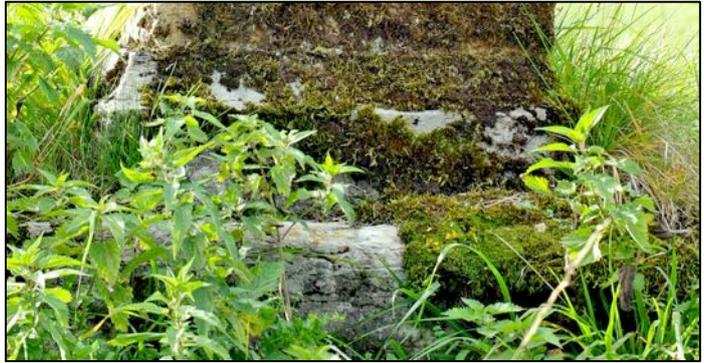
On peut discerner quelques éléments de mouluration de la base qu'il est toutefois difficile de décrire précisément du fait de l'usure de la pierre et de la présence de l'herbe et de la mousse. La base semble comporter plusieurs étages de moulures dont un quart de rond en partie haute.
