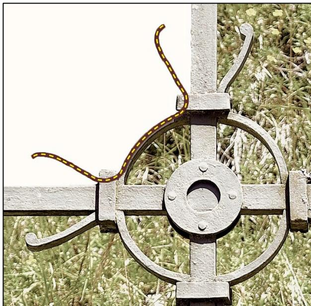
En fait, il est composé de quatre fers plats, forgés de façon habile, avec une partie centrale en quart de cercle et deux extrémités relevées à angle droit pour former les "branches" des duos de feuilles d'eau. Ces fers sont fixés aux tiges structurales par de puissants colliers en fer plat (sans vis papillon, l'ensemble du décor étant suffisamment rigide pour éviter les déformations).
