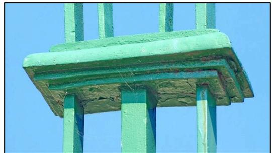
Il est difficile de voir si les fers latéraux de l'allonge se poursuivent ou non au niveau du croisillon (fers extérieurs) à travers la platine. Seul un démontage de la structure permettrait de le savoir. Structurellement, les branches du croisillon sont constituées d'un agencement de différents modules en fer plat.
