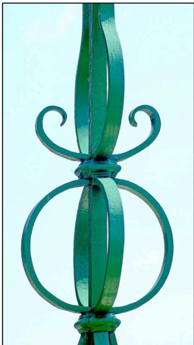
À noter l'amincissement des extrémités des fers plats au niveau des volutes comme aussi aux extrémités des enroulements à la base des consoles.
