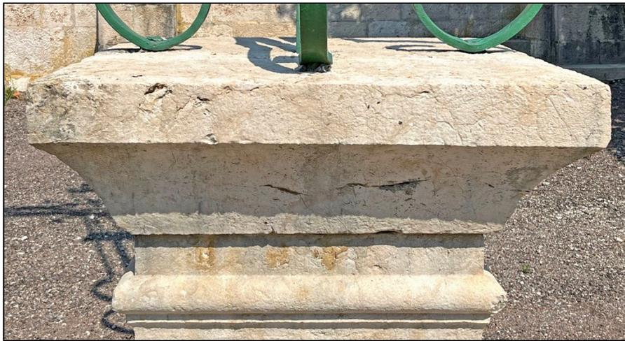
La vue ci-contre montre le scellement des fers des consoles sur la corniche. La fixation est réalisée par des pointes enfoncées en force, avec rivetage des têtes et ajout de plomb de scellement.
