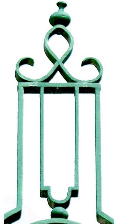
Le décor E à l'extérieur des branches est un culot en un seul tenant réalisé en fer plat (intersection-assemblage à mi-fer). Un bouton (ou graine) en fer moulé ou étampé prolonge la boucle en amande du culot.
