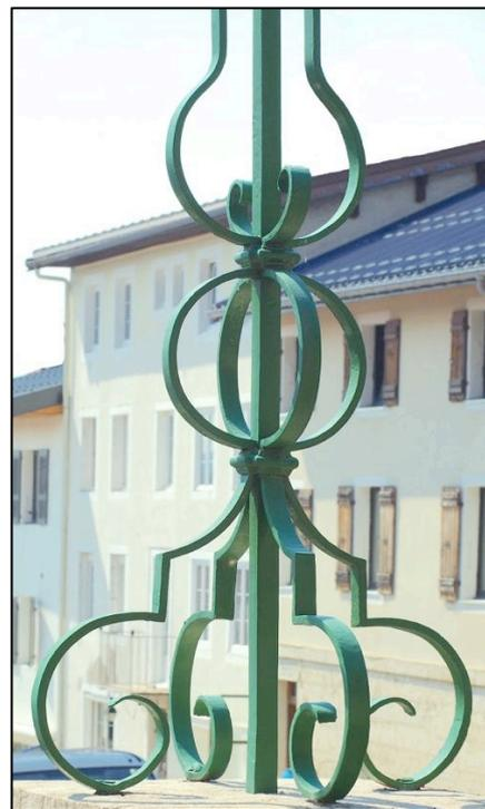
Les quatre consoles, en fer plat assez large, sont installées sur les axes principaux du piédestal et donc de la croix et non pas sur les diagonales de la corniche (comme c'est très souvent le cas). Ces consoles viennent soutenir, en partie haute, la tige structurelle centrale.
