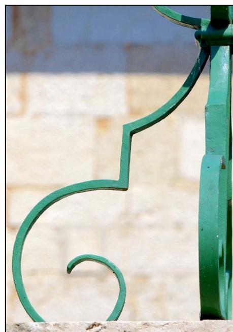
Leur profil ou dessin est sobre et ferme, avec un large enroulement en bas qui ne tangente pas la tige centrale. Suit un angle droit qui permet de redresser les fers à la verticale. Enfin, ceux-ci rejoignent le collier grâce un arc de cercle surbaissé très élégant.
