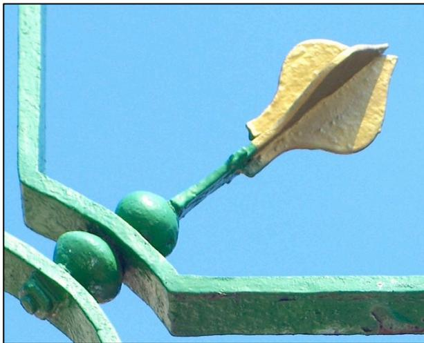
Les flèches F présentes dans les quatre angles externes des branches sont réalisées à partir de deux tôles de fer découpées s'emboîtant l'une dans l'autre. L'une des tôles est prolongée pour former la hampe de la flèche, elle-même passant à travers les perles de liaison. Au-delà de la hampe, la tige en fer passe aussi à travers les deux fers plats circulaires avant d'être boulonnée sur le fer central C.
