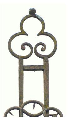
Les fers structurels formant les bords de la croix sont assemblés "à mi-fer" au centre de la croisée, de discrets rivets assurant la fixation des fers.
