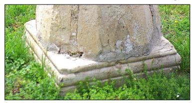
La base du piédestal est une dalle calcaire de plan carré. Elle présente une élégante mouluration avec de bas en haut une petite plinthe, un large quart-de-rond aplati et, enfin, un plus petit quart-de-rond. Ce plan carré permet de positionner judicieusement le dé en tronc de pyramide pour faire ressortir les angles abattus du dé pyramidal.
