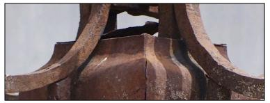
On note également que les rouleaux bas des consoles sont fixés sur la corniche par l'intermédiaire de petite plots en fer de section carrée scellés, eux, dans la pierre.
