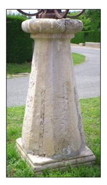
Le dé en forme de tronc de pyramide est un bloc monolithique. À noter la présence de plusieurs et étranges fentes verticales comblées au ciment sur certaines des faces du tronc de pyramide. La blancheur de la pierre fait bien ressortir l'élégance de ce piédestal comme aussi le beau contraste avec la teinte "rouille" de la croix métallique.
