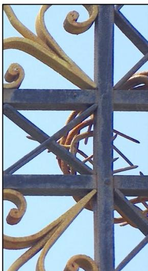
Les fers structurels sont assemblés à mi-fer au niveau de la croisée des branches avec solidarisation par de discrets rivets.
