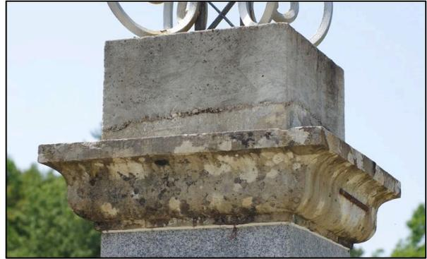
Au-dessus du dé (habillé de plaques de marbre), est posé une belle corniche, également en pierre calcaire (vraisemblablement d'origine).
