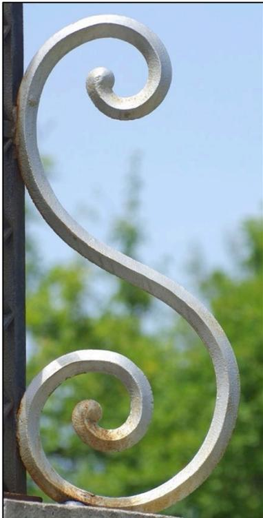
Les consoles sont en forme de S avec gros rouleaux en partie basse et plus petites volutes en partie haute. Les fers des consoles se présentent “sur angle”, disposition élégante mais qui rend plus difficiles les fixations et assemblages.
