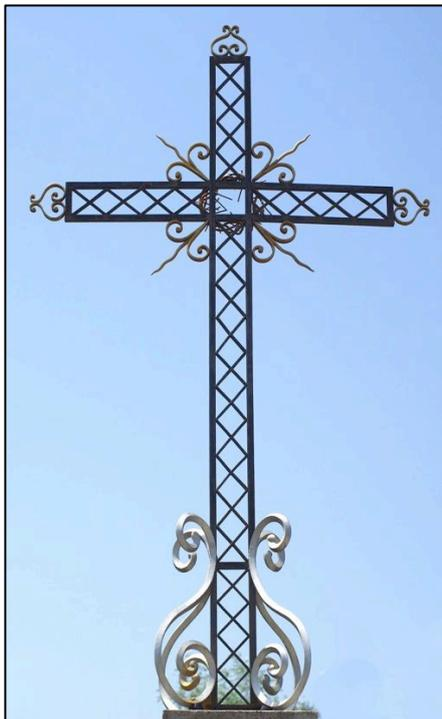
Les deux longs fers montants parallèles sont assemblés, au niveau de la croisée des branches, avec les deux fers horizontaux de la traverse (assemblage à mi-fer).
