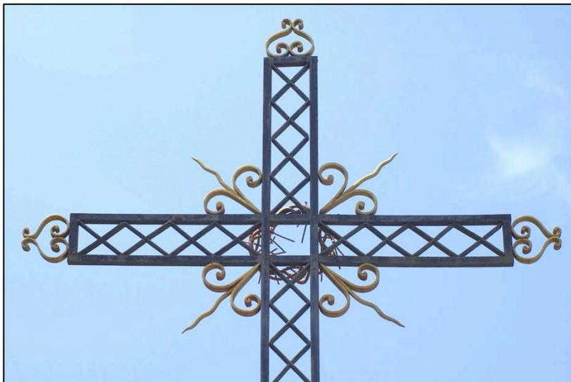
Le principe constructif est le même que pour le pied de la croix avec de gros fers structurels de section carrée.
