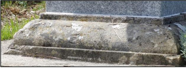
La base - d'origine - du piédestal est un beau bloc calcaire comportant une petite plinthe surmontée d'une moulure en quart de rond et enfin d'un réglet. La pierre est bouchardée.
