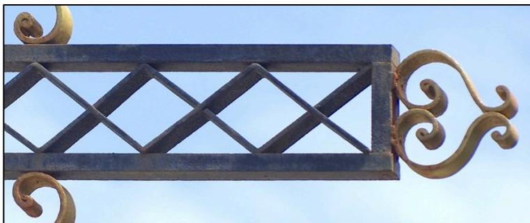
Des fers orthogonaux assurent la clôture des branches : ils sont fixés sur les fers structurels de bord par tenon et rivetage.
