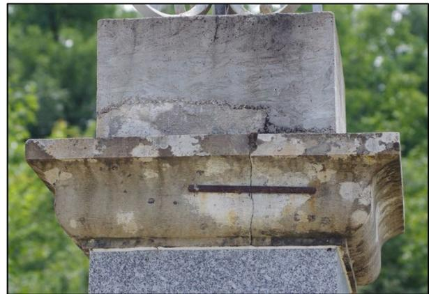
Le tailloir parallélépipédique, au-dessus de la corniche, semble être pour partie celui d'origine (en pierre calcaire bouchardée) et pour partie consolidée avec du béton banché.
