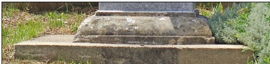
Le piédestal s'élève sur une dalle de sol qui semble être en béton.
