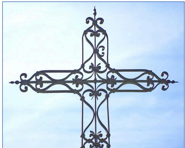
Les deux fers plats structurels centraux se croisent, eux, au centre de la centre. Le fer vertical subit ici une torsion à 180° de façon à pouvoir laisser passer le fer central horizontal.
