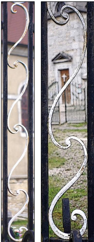
Entre les deux montants structurels se déploie un décor de remplissage composé d'une frise de S étirés en fer plat. Les quatre motifs en S se lient entre eux par les noyaux de leurs volutes (ils semblent se tenir la main).
