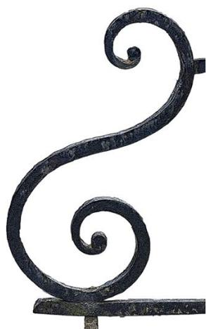
La croix est étagée, en pied, par quatre consoles en forme de S à rouleaux (en bas) et à volutes (en haut). Elles sont réalisées en fer de section carrée allant en s'amincissant vers les extrémités. Là, les fers ne présentent que de petits et simples noyaux.
