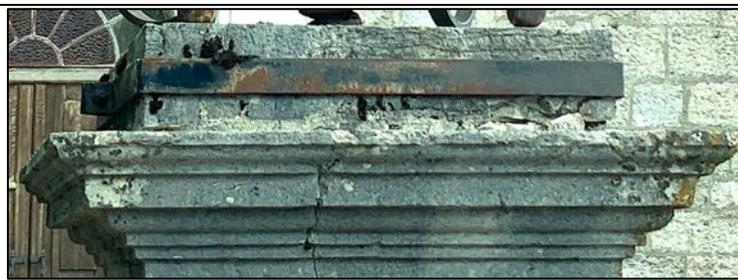
En haut est posée une corniche très moulurée avec succession de plusieurs régles encadrant un quart-de-rond, un bandeau et un talon. Un tailloir parallélépipédique (renforcé par une ceinture en fer) est posé sur la corniche.
