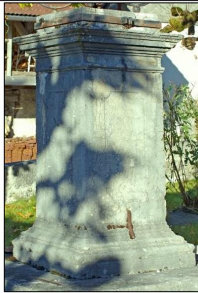
Ce piédestal en calcaire, assez élancé, comporte, en pied, une base avec succession de moulures : petite plinthe, tore, premier régle, talon renversé et second régle.
