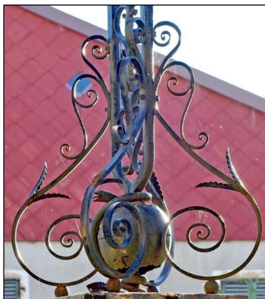
Après les consoles, les fers structurels changent de forme de section. En bas ils sont à section circulaire ou vaguement octogonale puis reprennent leur section carrée originelle en montant.
