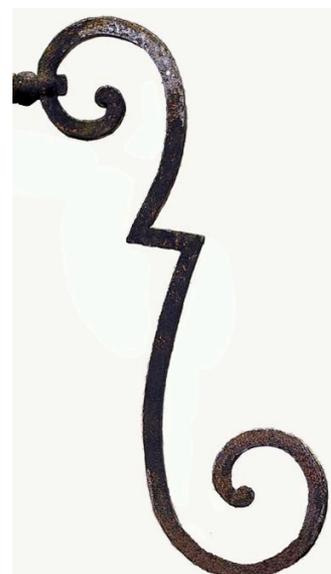
Les consoles sont en forme de S à volutes aux extrémités des fers. Par contre, le profil du S, dans sa partie intermédiaire, entre rouleaux hauts et bas, semble avoir subi un mouvement "tectonique", se traduisant par la création d'un sévère redan, formant zigzag. Ce profil de console est rare et, à la croix de Moirans, on semble avoir eu envie d'innover.
