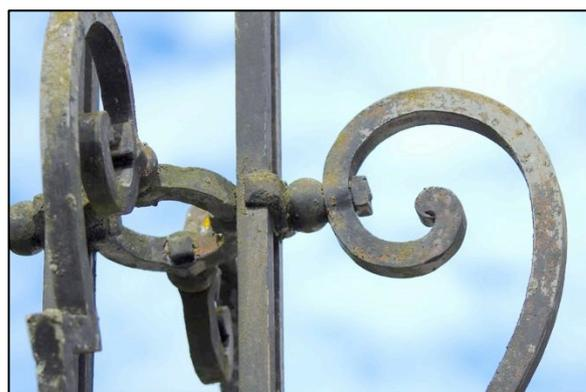
La fixation sur l'entretoise annulaire des deux consoles d'avant et d'arrière de la croix se fait par le biais d'un long boulon liant ensemble l'anneau, une grosse perle en fer étampé puis le fer de la volute. Pour les deux consoles latérales, la fixation est plus complexe et nécessite l'ajout d'un étrier enserrant et maintenant solidement le duo de fers structurels montants.
