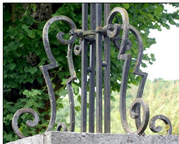
La croix est étayée, en pied, par quatre consoles en fer forgé au dessin assez sophistiqué, également d'esprit plutôt novateur. On voit bien, une fois la structure bien perçue et comprise, les deux duos de fers montants formant le pied ou fût de la croix, avec les perles en fer étampé reliant et solidarissant les fers des duos.
