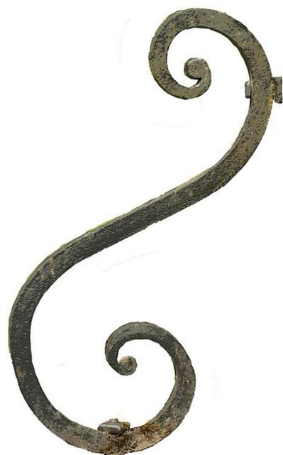
En partie basse, les gros rouleaux ne s'appuient pas sur les fers bordiers (ils en sont écartés). La fixation des rouleaux sur le socle de pierre se fait par boulons et écrous (refixation tardive?).
