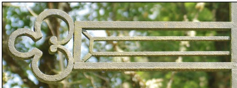
De beaux trilobes à volutes intérieures, en fer forgé, sont placés aux extrémités des branches, fixés par de discrets rivets aux barrettes orthogonales d'extrémité.
