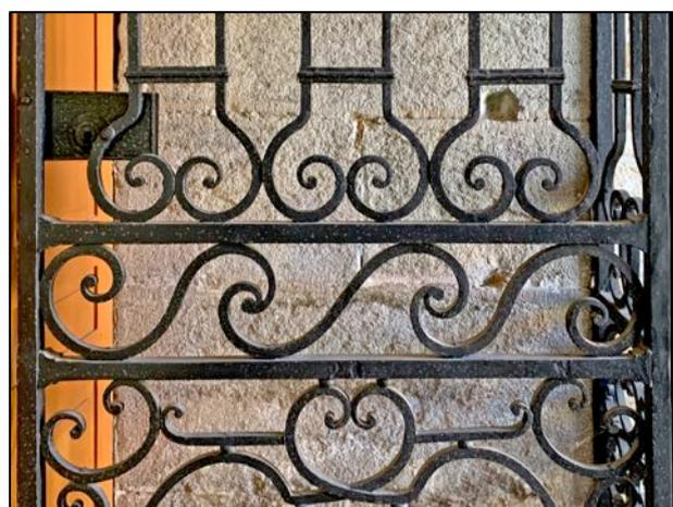
Le portail est composé de deux puissants et beaux battants ou venteaux ouvrant vers l'intérieur de la nef. En partie basse, ces battants comportent des panneaux rectangulaires avec un élégant décor de style classique (à courbes, ovales et volutes en fer forgé de section carrée).
