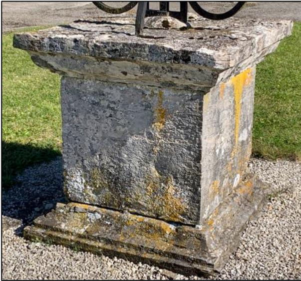
Ce piédestal, peu élancé et plutôt sobre, est de forme parallélépipédique et de section carrée. Il est composé de trois blocs calcaires superposés.
