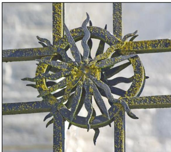
Au cœur de la croisée, le formage et l'assemblage des quatre fers structurels conduisent à créer l'illusion d'un cercle. Il ne s'agit pas d'un vrai cercle mais d'un assemblage, en continuité, des quatre arcs de cercle. La courbure accentuée de ces arcs de cercle du côté de l'intérieur des branches confère à ce cercle virtuel une allure de "cercle à bosses".
