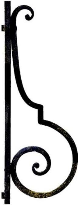
Les ailerons (“fausses consoles”) sont particulièrement élégants, avec un gros rouleau en partie basse, un redan vertical au sortir du rouleau, enfin une courbe aplatie se terminant par une volute en partie haute. Le fer de section carrée des ailerons est progressivement aminci au niveau des extrémités (volute), ce qui témoigne d’un travail de ferronnerie très soigné.
