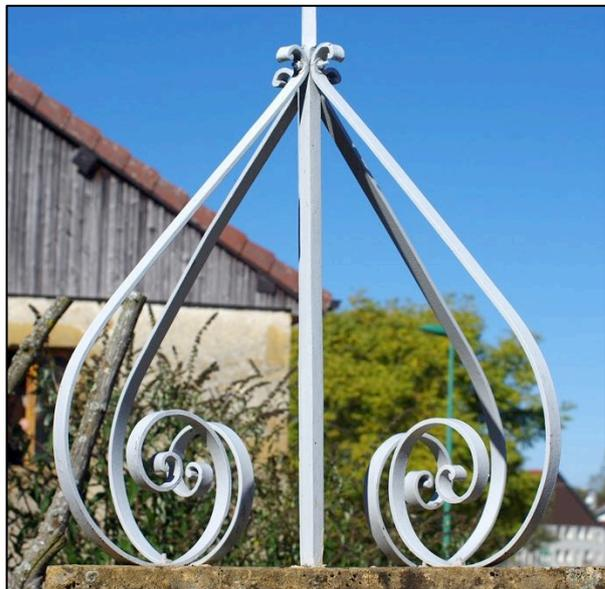
Les consoles en fer plat sont en forme de S, avec de gros enroulements en partie basse. Après une longue ascension régulière et linéaire selon une direction à 45°, les fers se terminent, en partie haute par de toutes petites volutes. Le dessin des consoles est globalement peu recherché.
