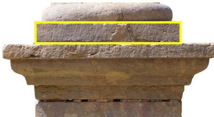
On discerne, sur une des faces, une fissure (en partie comblée par du ciment), fissure se prolongeant dans la moulure torique de la base du fût-colonne.
