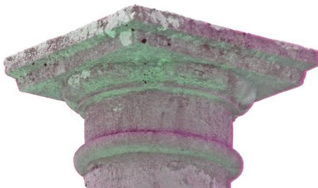
Le haut de la colonne comporte d'abord une moulure torique. Puis vient la partie terminale de la colonne, avec un petit tore circulaire suivi d'un quart de rond également circulaire.
