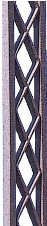
Le décor est en fait réalisé à partir de deux longs fers plats plusieurs fois pliés ou coudés et se croisant avec un assemblage dit à mi-fer.
