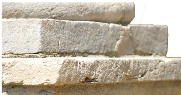
Si structurellement, le tailloir est ici lié au fût-colonne, visuellement il est aligné sur les faces du dé du piédestal, ce qui nous fait le rattacher au piédestal.
