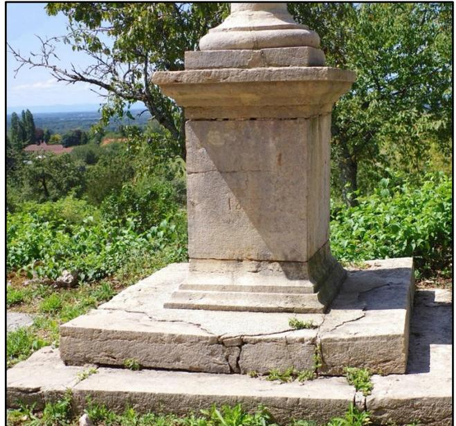
Celui-ci repose sur un emmarchement à deux degrés en dalles de calcaire qui semble souffrir d'un affaissement du terrain (fissures dans les dalles avec impact sur le piédestal).
