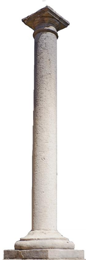
La base du fût-colonne repose sur la table supérieure de la corniche du piédestal. Elle se compose, en partie basse, du tailloir, évoqué plus haut, petit parallélépipède de plan carré et de faible hauteur. Elle se prolonge par une belle couronne à moulure torique. Après un petit réglot vertical, une doucine renversée peu accentuée fait le lien avec la colonne cylindrique.
