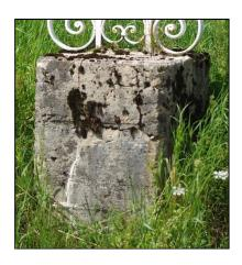
La croix en fer est ancrée sur un socle parallélépipédique en béton, peu esthétique et manifestement réalisé tardivement.
