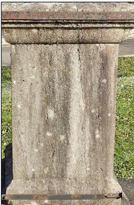
Bloc monolithique placé de chant, le dé calcaire semble fragilisé par des fissures verticales qui ont rendu nécessaire la pose de ceintures en fer plat.
