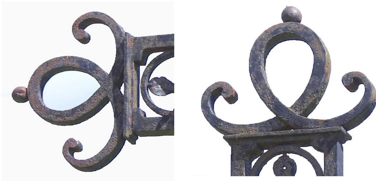
Les culots externes, en forme de boucle, sont réalisés en fer forgé avec croisement et assemblage à mi-fer et avec amincissement du fer et retour en volute à chaque extrémité de la boucle. De petites perles en fer étampé sont disposées au sommet des boucles.
