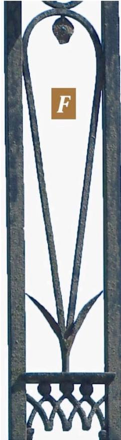
Le haut du pied-fût comporte un décor de remplissage spécifique. Il est basé sur un module consistant en un fleuron [F] avec deux feuilles saillantes en tôle de fer et une fleur ou graine en forme de boucle ou amande en fer forgé.
