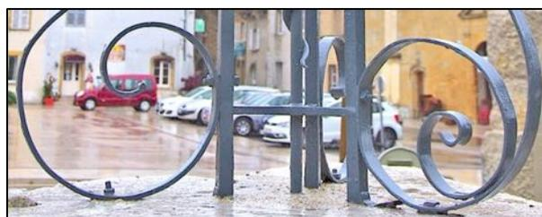
À noter la fixation des branches de l'entretoise sur les trois fers montants par l'intermédiaire de trous à renflement ménagés dans ceux-ci, puis par boulonnage des fers.
