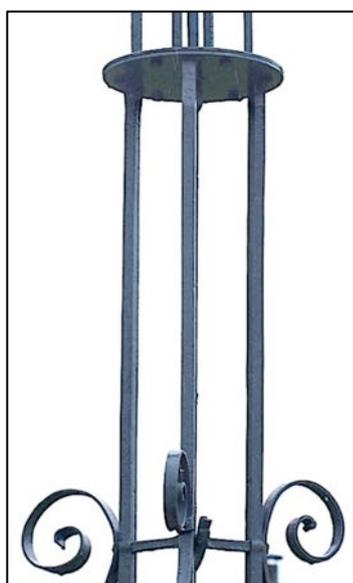
La partie haute du fût ne comporte que les quatre fers montants (le fer rond central et les trois fers latéraux de section carrée). Aucun décor n'est intégré au volume virtuel ainsi créé. En partie haute, les fers structurels viennent se fixer sur un disque avec moulure en périphérie, qui va ensuite supporter les quatre fers latéraux du croisillon et un 5<sup>ème</sup> fer central.
