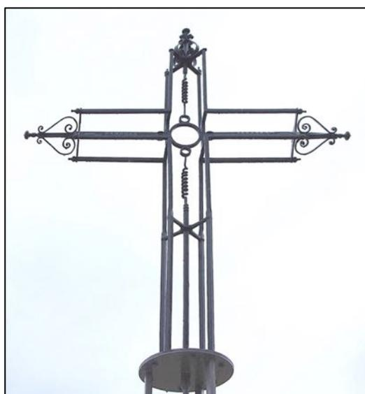
Au-dessus du disque de liaison, le pied du croisillon se présente comme un volume parallélépipédique dont les arêtes sont constituées de quatre fers carrés. Ces fers latéraux ou de bordure sont de section plus petite que celle des trois fers montants du fût.
