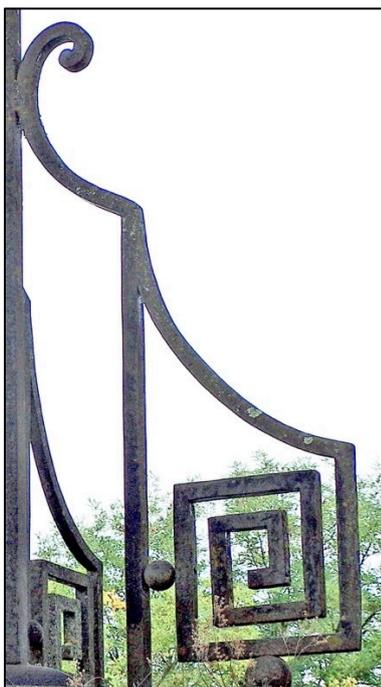
Elles comportent un haut fer vertical scellé dans la pierre de la corniche et placé à mi-chemin entre montant d'angle du fût-cage et perle d'appui de la spirale à segments de droites.
