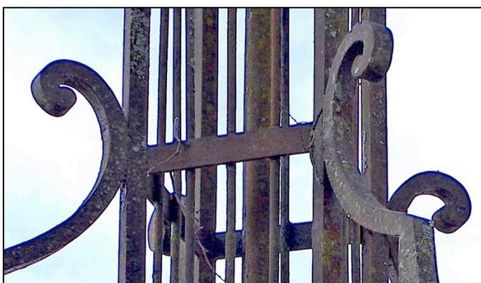
À l'endroit où les petites volutes supérieures sont fixées aux montants d'angle du fût-cage, un fer plat forme une ceinture de rigidification de l'ensemble de la structure.
