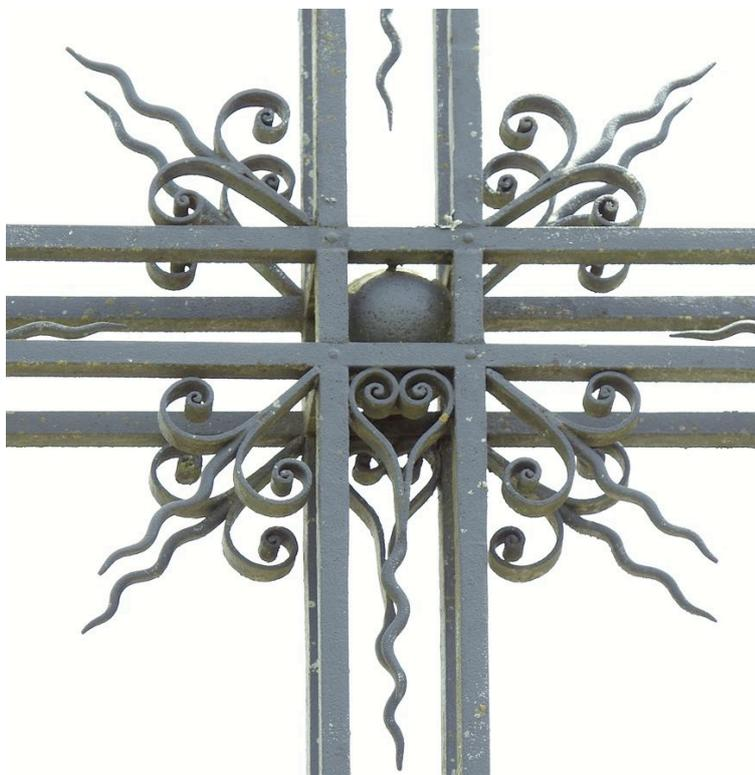
Notons d'emblée l'assemblage discret et efficace ("à mi-fer") des montants verticaux et horizontaux des branches de la croix.
