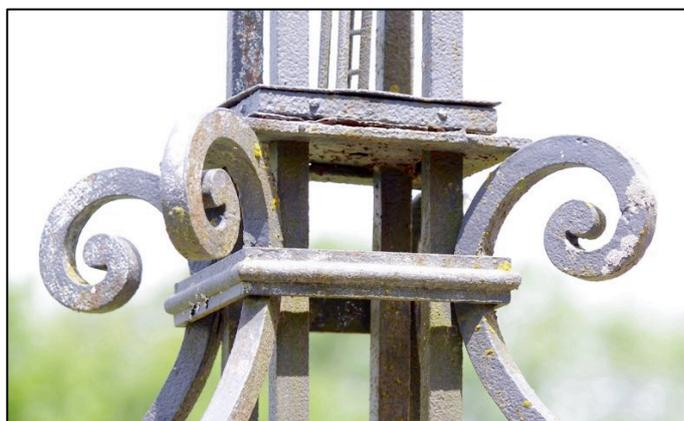
Les quatre montants de la base sont fixés, en partie haute, à une platine carrée de faible épaisseur qui permet, d'une part de maintenir écartés ces fers verticaux et, d'autre part, de recevoir une seconde platine, plus épaisse.
