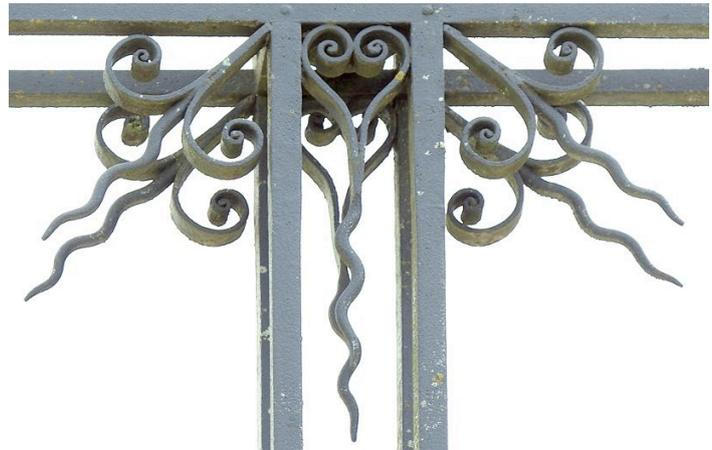
Dans le haut du fût, entre les fers verticaux et s'assemblent sur deux des faces du fût, ont été disposés deux exemplaires d'un motif classique de ferronnerie d'art, à savoir une sorte de cœur à volutes et dont la pointe se termine par une vrille en queue de cochon. C'est là encore une solution décorative qu'on observe à Syam (mais à Picarreau, on ne compte que deux motifs).
