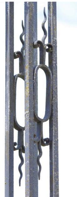
Il est intéressant de souligner le fait qu'on ne relève pas la présence de tête de vis ou de rivet sur les montants du fût comme sur les fers des ovales, ce qui pourrait laisser penser à un dispositif de fixation caché, assez sophistiqué (emboîtement).
