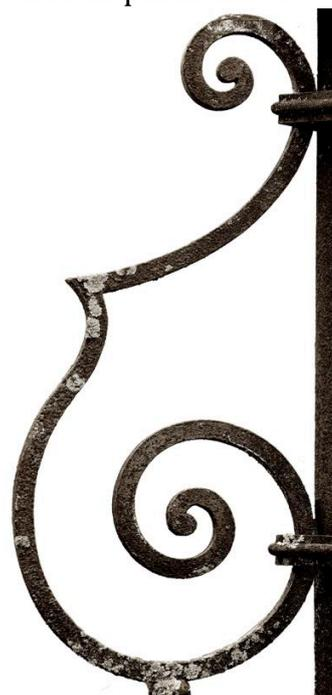
Ces colliers à baguette torique, formant ceinture, sont une solution judicieuse pour assurer la liaison mécanique entre les fers des montants et ceux des consoles. Les montants ont leurs faces orientés selon les plans principaux du piédestal alors que les fers des consoles ont leurs faces orientées selon les diagonales de la corniche (angle de 45°). Le collier évite un vissage ou boulonnage complexe (fixation sur angle).
