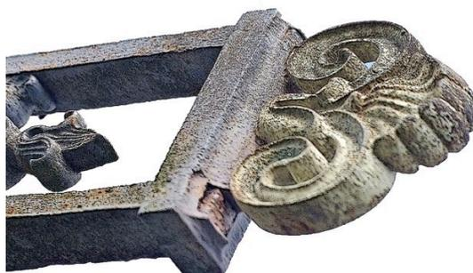
Une subtilité particulière réside dans l'ajout de deux monogrammes (ou mots) en fer plat forgé, "ave" et "crux". Les lettres en fer plat (écriture cursive anglaise) sont fixées entre elles par de discrets rivets. Les mots ainsi formés sont fixés aux montants structurels par des boulons et écrous.
