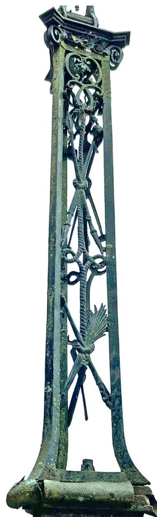
Le décor en tôle de fer étampé représente des instruments de la Passion du Christ et d'autres symboles religieux. Il se répartit sur deux étages de la colonne-fût. Tous ces éléments de décor en tôle de fer sont fixés par de discrets rivets aux montants structurels de la colonne-fût.
