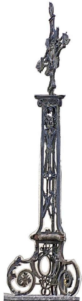
La structure porteuse (les trois consoles du tabouret) et les trois montants verticaux de la colonne-fût sont des fers de section carrée de forte dimension. Le décor intégré au tabouret est en fer forgé de plus petite section, auquel sont ajoutés des motifs décoratifs en tôle de fer étampée.
